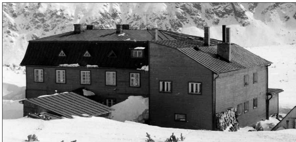
Kežmarská chata, ktorá vyhorela 7. októbra 1969, bola mnoho rokov druhým domovom Štefana Kovalčíka.
